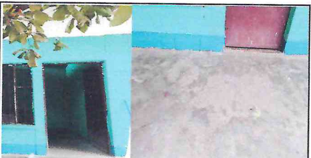
FOTO 5: SUSTITUCIÓN DE PISO CERÁMICO ANTIDESLIZANTE
