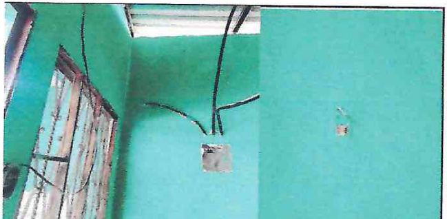
FOTO 6: REPARACIÓN DE CABLEADO ELECTRICO, SUSTITUCIÓN DE LÁMPARAS, SUSTITUCIONES DE FLIPONES, SUSTITUCIÓN DE PLAFONERAS, SUSTITUCIÓN DE TOMACORRIENTES DOBLES
