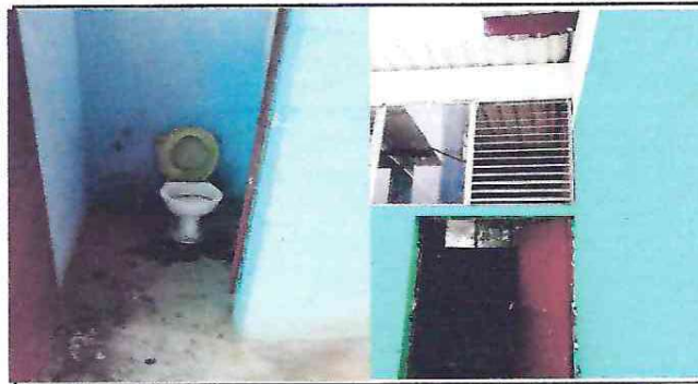
Foto 10: SUSTITUCIÓN DE INODOROS, SUSTITUCIÓN DE PUERTAS EN SERVICIO SANITARIO
