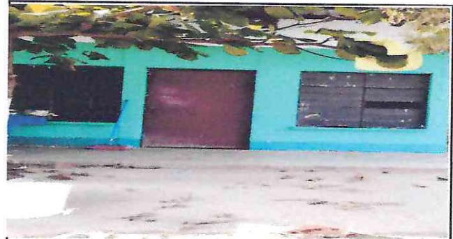
FOTO 4: SUSTITUCIÓN DE DOS VENTANAS DE VIDRIO
