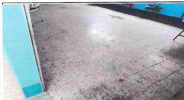
Foto 9: SUSTITUCIÓN DE PISO CERAMICO EN EL SALON
