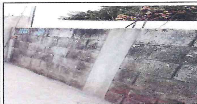
FOTO 11: PINTURA EN MUROS EXTERIOR E INTERIOR
