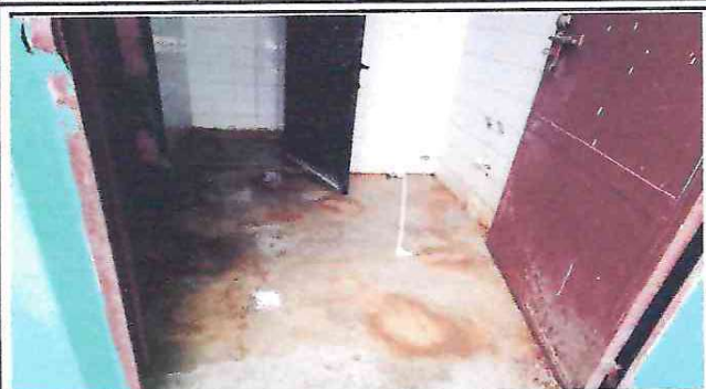
FOTO 7: SUSTITUCIÓN DE PISO CERAMICOS EN SANITARIOS
