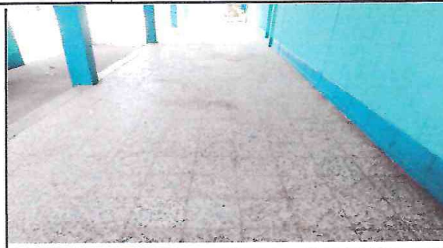
FOTO 8: SUSTITUCIÓN DE PISO DE CERAMICO EN EL CORREDOR
